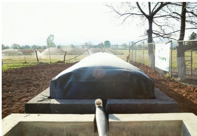
Ejemplos de biodigestores instalados por el IRRI para el tratamiento de estiércol en México
